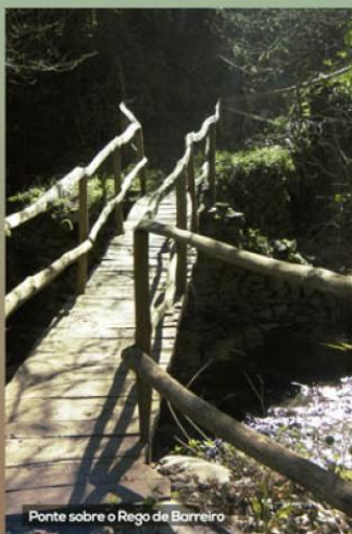
Ponte sobre o Rego de Barreiro
